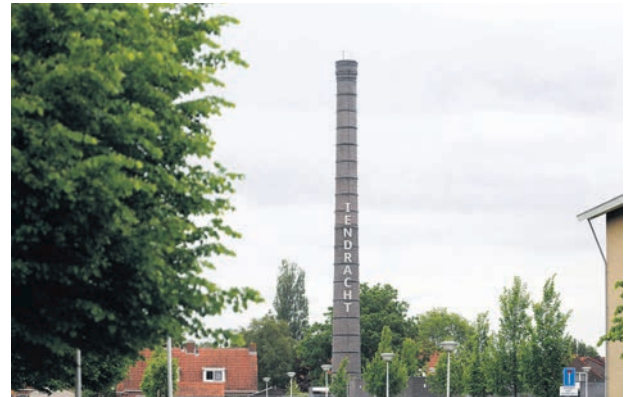
De schoorsteen van de in 2003 gesloopte melkfabriek Lendracht wacht maandag de slopershamer. Foto: Marchje Andringa
